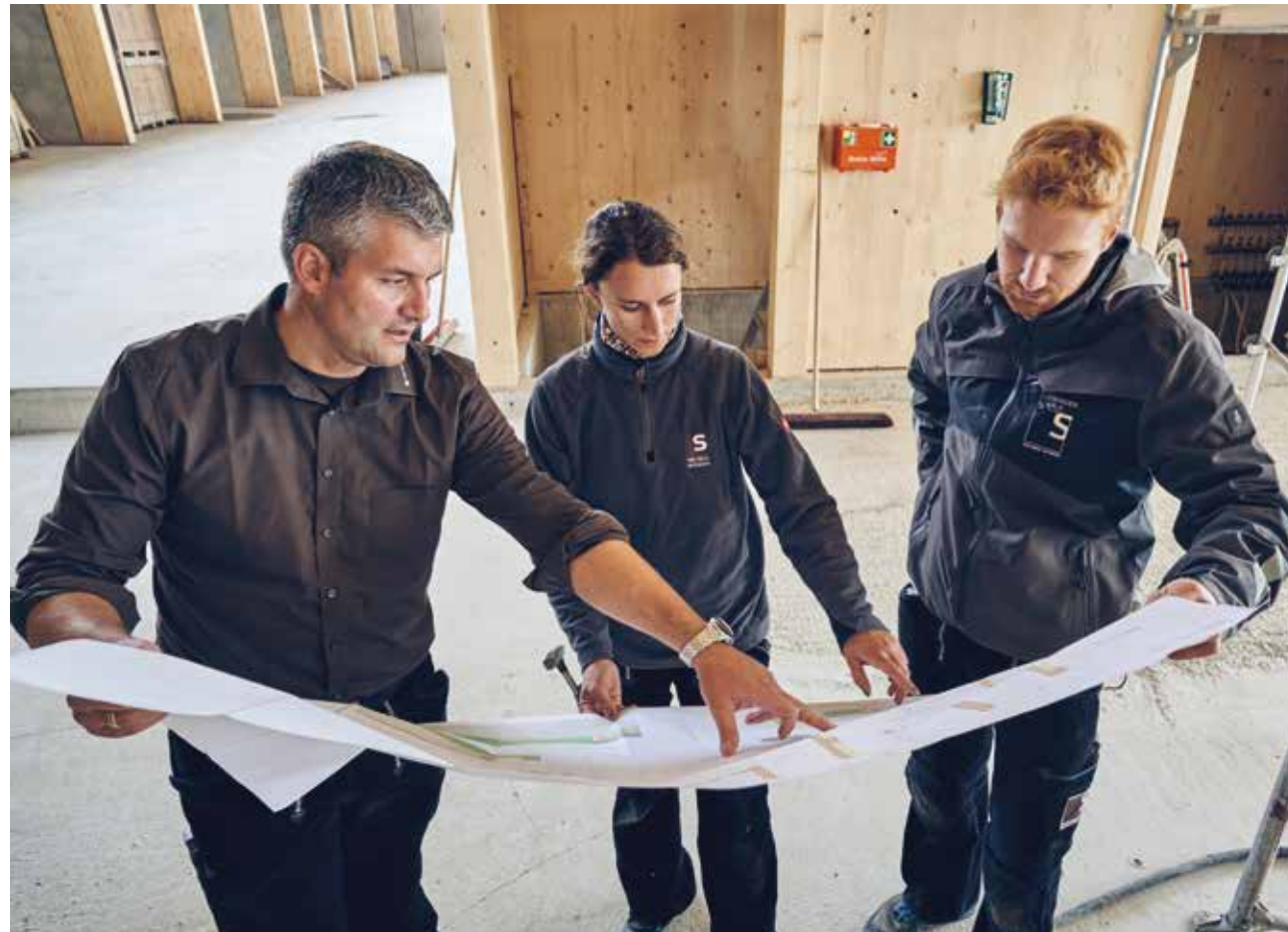
Der Neubau des Betriebsgebäudes schafft Platz für alle Mitarbeiter. Der Bau entsteht natürlich in Holz. Der Umzug in die modernen und komfortablen Räume steht im kommenden Jahr an.
